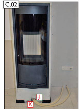
Ansicht vor Montagebeginn bei RONDO SC oder LINEARE SC mit bauseits vorbereitetem Leerrohr (J) und Leerrohr (K) sowie 3-fach-Steckdose.
