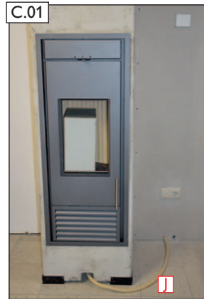
Ansicht vor Montagebeginn bei CLASSICO S mit bauseits vorbereitetem Leerrohr (J) und 2-fach-Steckdose.
