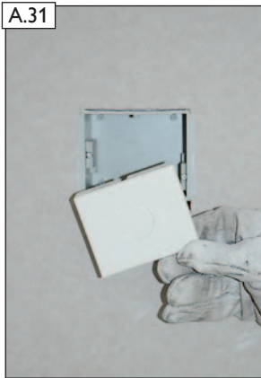
A.31 Abdeckung mit perforiertem Eingriffsloch in LEDA LUC Leerdose ...
