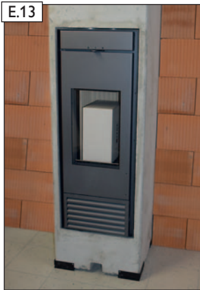
E.13 Ansicht Montagebeginn mit bauseitiger Vorrüstung 230V-Flexkabel und Potentialausgleichsleitung.
