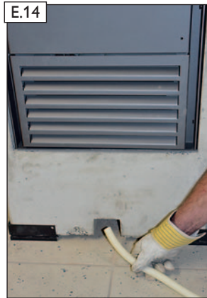
E.14 Verlegen der bauseitig erforderlichen Leerrohrverbindung vom KINGFIRE CLASSICO S zum bauseitigen Elektroschrank/Kleinverteileranlage.
