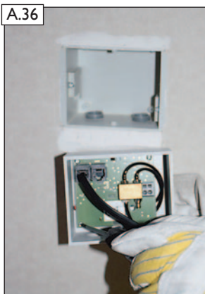
A.36 Original LEDA LUC Platine aus der Bedien- und Messeinheit entfernen ...
