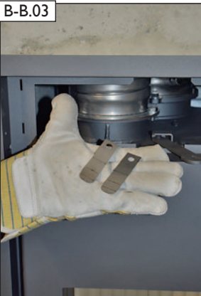
Die beiden Halteklammern für den Metallschutzschlauch ...
