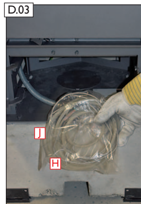
D.03 Ansicht des werkseitig vorinstallierten Druckmessschlauches (H) (5,0m) und Temperaturfühlers (J) (5,0m).
