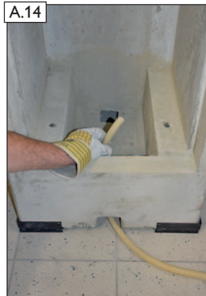
Leerrohr verbleibt im Hohlraum der KINGFIRE-Feuerstätte.
