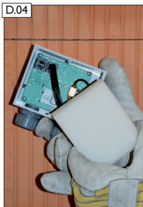
D.04 Schutzschwamm in LEDA LUC Bedien- und Messeinheit einlegen.
