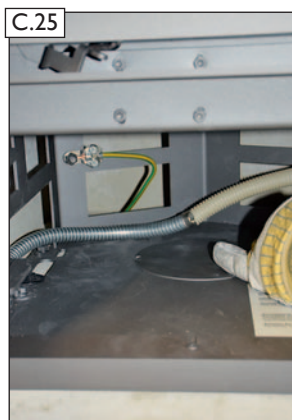
Fertigansicht mit eingelegtem Revisionsdeckel.
