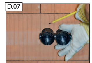
D.07 ... bauseitig gewünschte Einbauposition für 2-fach-Steckdose festlegen. HINWEIS! Bei LINEARE SC, RONDO SC und GRANDE SC-Geräten ist eine 3-fach-Steckdose vorzusehen.
