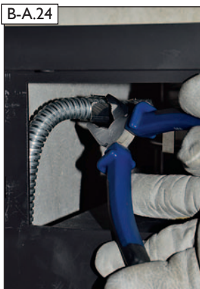
B-A.24 Metallschutzschlauch an der Schutzschlauchführung festklemmen.
