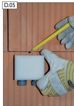
D.05 Bauseitig gewünschte Einbauposition festlegen. WICHTIGER PLANUNGSHINWEIS! Max. Leitungslänge von 3 m für Druckmessschlauch und Temperaturfühler beachten!
