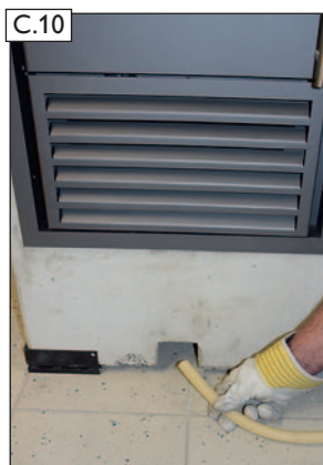
Bauseitiges Leerrohr in die werkseitige Montageöffnung des KINGFIRE-Betonmantels einbringen.
