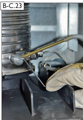
B-C.23 ... in die Öffnung des Verbindungselementes einstecken und mit der Fixierschraube sichern.
