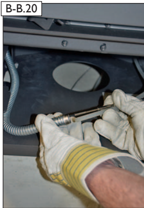
B-B.20 Druckmessschlauch und Temperaturfühler von bauseitigem Leerrohr in Metallschutzschlauch einfädeln und ...
