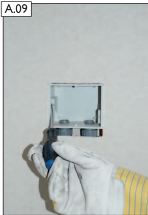
LEDA LUC Leerdose montieren.
