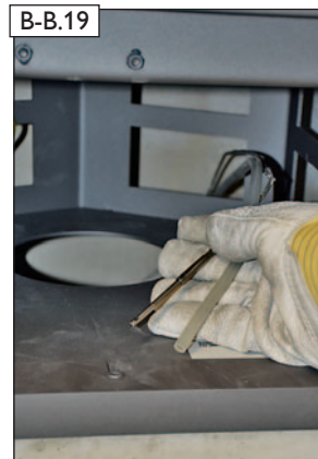
B-B.19 Bauseitigen Druckmessschlauch und Temperaturfühler „herausangeln“ und von außen in den Bereich der Konvektionsluftöffnung der Brennkammer führen.
