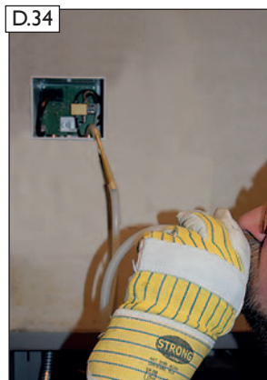
Eine Funktionskontrolle auf freien Durchfluss im Druckmessschlauch ist im Anschluss vorzunehmen.
