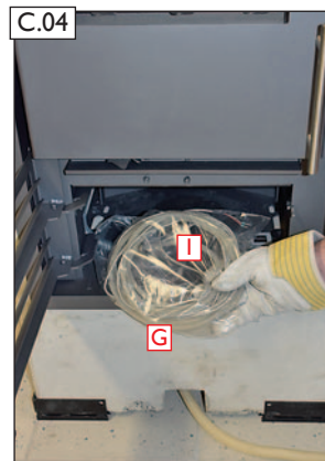
Ansicht des werkseitig vormontierten Druckmessschlauches (G) (7,0m) und Temperaturfühlers (I) (7,0m).
