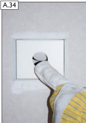
A.34 Perforiertes Eingriffsloch eindrücken.
