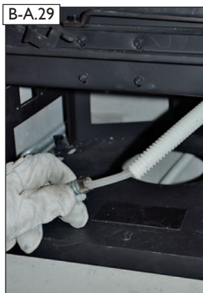
B-A.29 ... vollständig bis zum LEDA LUC Gehäuse in der bauseitigen Wand weiter einfädeln.
