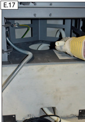
E.17 Bauseitiges Leerrohr von hinten durch die rückseitige Öffnung der Brennkammer einfädeln.
