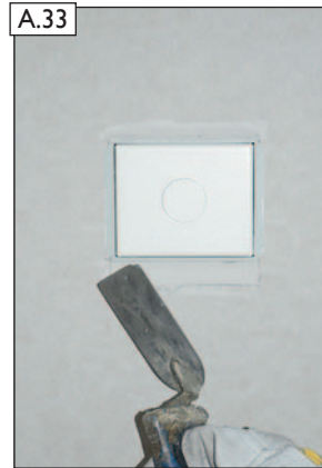
A.33 Abschlussarbeit: Verbleibende Montageöffnungen um die LEDA LUC Leerdose bauseits verschließen (beispachteln).
