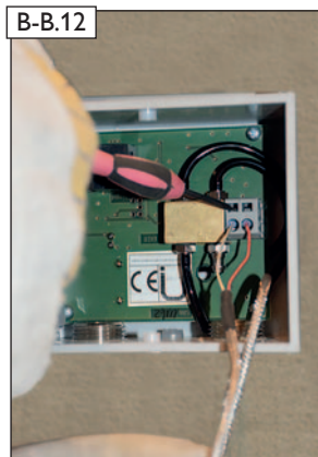
Temperaturfühler in der Bedien- und Messeinheit gem. Schaltplan verklemmen.
