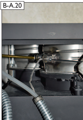
B-A.20 Temperaturfühler vollständig in die Öffnung des Verbindungselementes einstecken und mit der Fixierschraube sichern.
