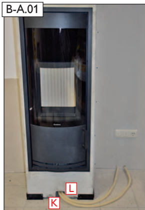
Ansicht vor Montagebeginn.
