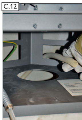
Bauseitiges Leerrohr „herausangeln“ und von außen in den Bereich der Konvektionsluftöffnung der Brennkammer führen.
