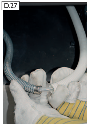
Vormontierten Druckschlauch und Temperaturfühler bis zum bauseitigen Leerrohr A knickfrei vollständig einfädeln.
