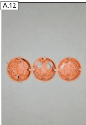
Bauseitige 3-fach-Steckdose nach Herstellervorgaben versetzen und Leerrohre einarbeiten.
