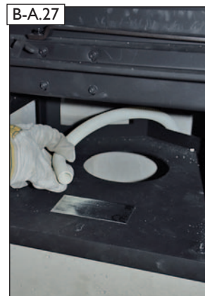
B-A.27 Bauseitiges Leerrohr „herausangeln“ und von außen in den Bereich der Konvektionsluftöffnung der Brennkammer führen. WICHTIG! Nicht durch die Revisionsdeckelöffnung verlegen!
