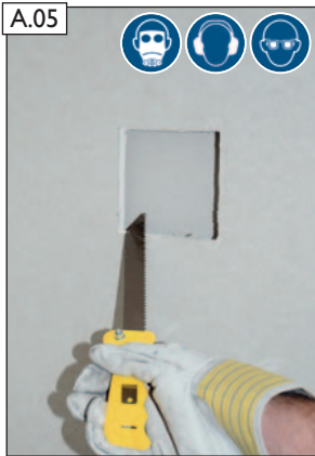
Bauseitige Montageöffnung für die LEDA LUC Leerdose herstellen.
