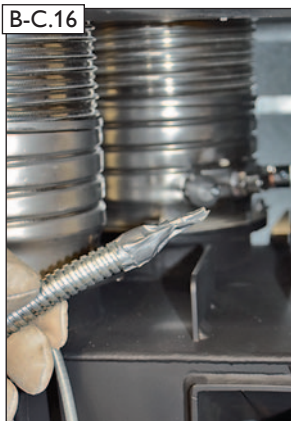
B-C.16 Druckmessschlauch und Temperaturfühler mit Klebeband gegen Beschädigungen und Herausrutschen aus dem Metallschlauch sichern.
