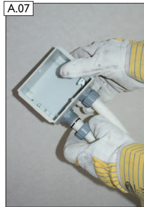
Leerrohre mit Verschraubungen und Sicherungsring an der LEDA LUC Leerdose verschrauben.
