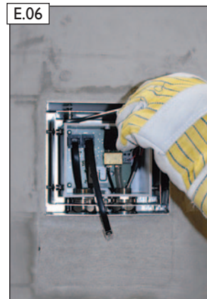
Vor der Montage des Blendrahmens kann das Gehäuse der Bedien-/Messeinheit bei Bedarf nachjustiert werden. WICHTIG! Gehäuse dabei nicht beschädigen!
