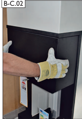
Obere Verkleidung der Brennkammer entfernen.
