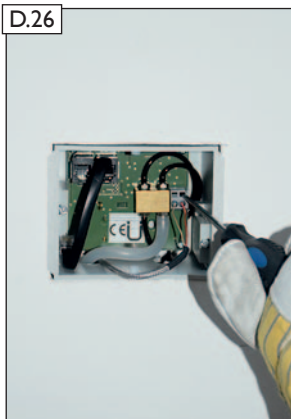
Temperaturfühler der LEDA LUC Bedien- und Messeinheit anklemmen.
