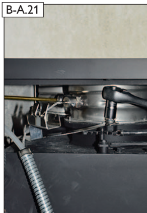
B-A.21 Schutzschlauchführung mit vorderer Befestigungsschraube am Abgasadapter befestigen und ... WICHTIG! Noch nicht festziehen!
