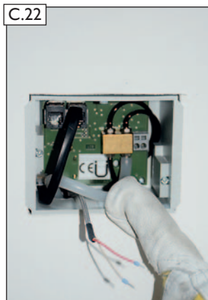
Druckmessschlauch an LEDA LUC Bedien- und Messeinheit anschließen.
