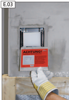
Innere Schutzabdeckung entfernen.
