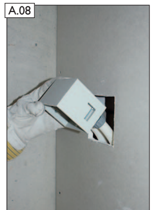
LEDA LUC Leerdose zusammen mit den vormontierten Leerrohren in die Montageöffnung einführen.
