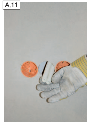
Leerrohre zur Öffnung der 3-fach-Steckdose verlegen. Leerrohre zur Montage in der bauseitigen 3-fach-Steckdose auf erforderliche Länge einkürzen.
